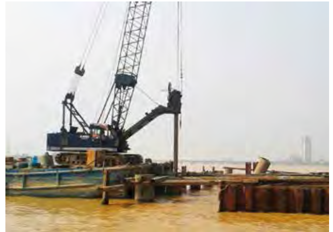
D1000 concrete pillar.
