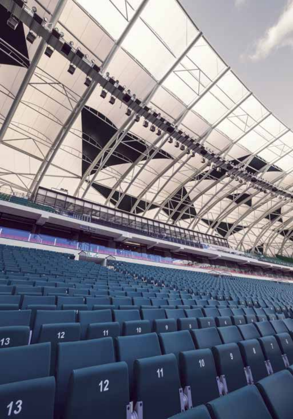
Photographer: Ket Kolektif
